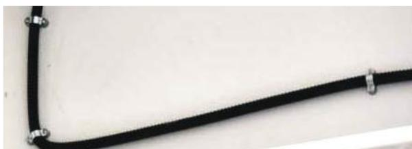
2. Passez la gaine dans le tube carré et effectuez les connexions électriques en respectant les couleurs. Attachez les fils avec des serre-câbles et insérez-les dans le tube carré.
